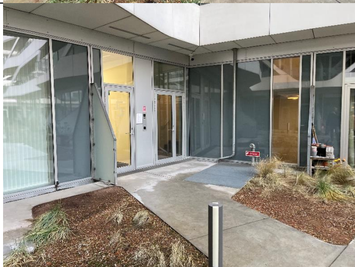
Beton belægning ud for nr. 5
